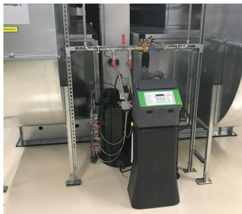
Abb. 1: VE-Wasseraufbereitung Luftbefeuchtung
